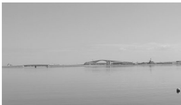
森山堤防の60m開削部
