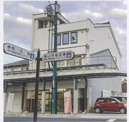
自然再生センター外観
