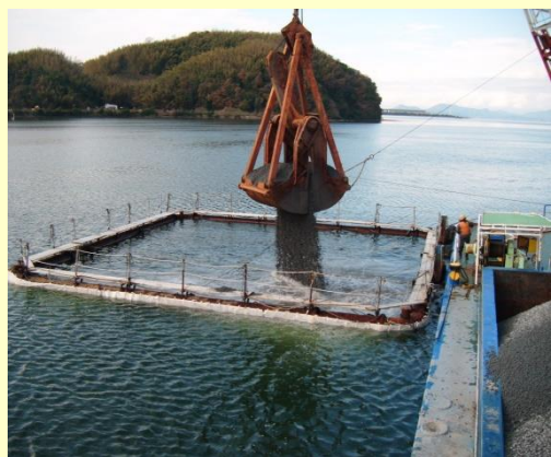
▲中海浚渫窪地埋め戻し
