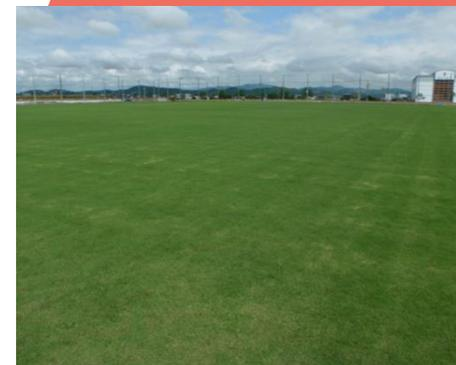
サッカーグラウンドの基盤と芝床の間にライトサンドを敷設。透水性と保水性が高まり、芝生の植生も良好
